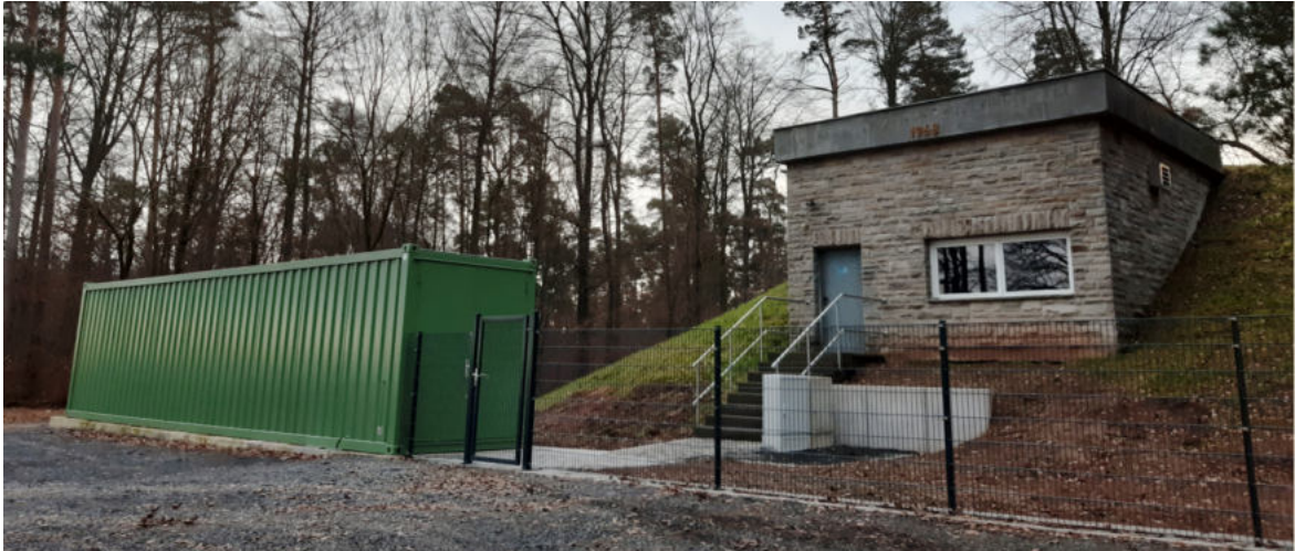
Platzierung einer SIWAbbox am Hochbehälter
